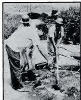
W. Driessen: "het water is hier zeer goed."
